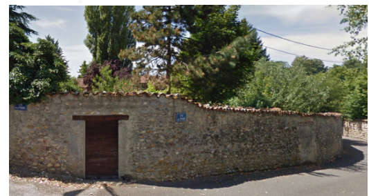
Soubassement en galets visible.
