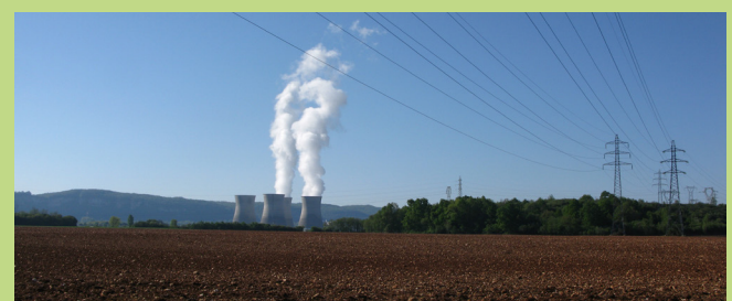
La centrale du Bugey comme élément de repère du territoire
