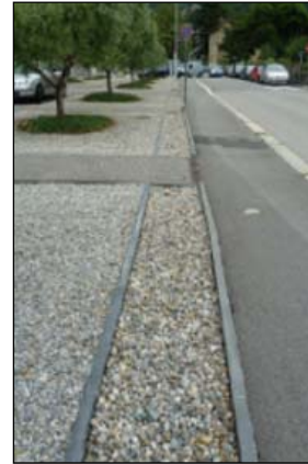
Puits et tranchées d'infiltration
