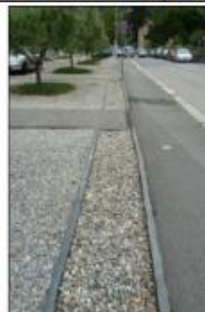
Puits et tranchées d'infiltration
