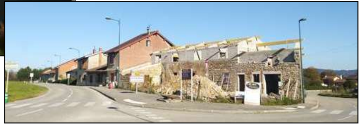
Entrée et réhabilitation en cours à l'automne 2022
