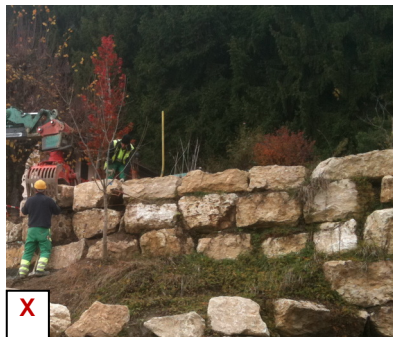
Enrochement de type cyclopéen
