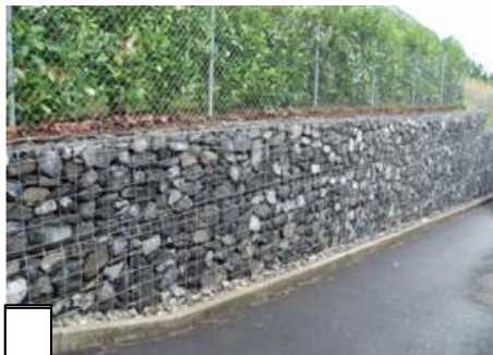
Muret en gabion
