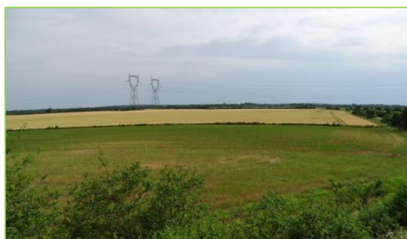
Traversée des lignes à très haute tension à l'Est
