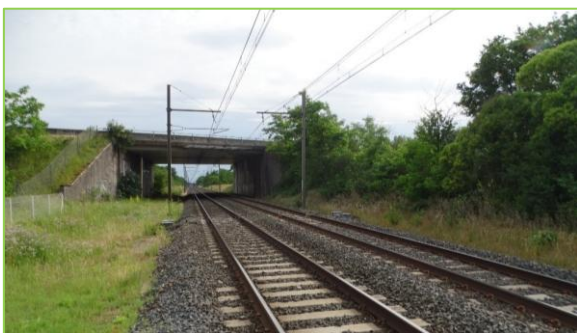
Ligne ferroviaire sur Béligneux
