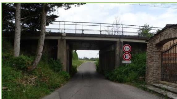
Passage de la route de Chânes sous la ligne ferroviaire
