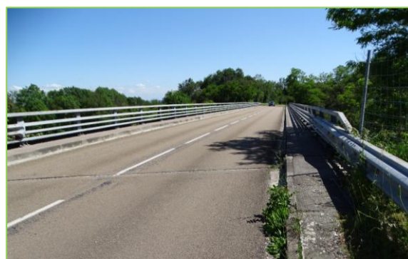
Passage de la montée de Béligneux (RD 84b) Au-dessus de l'autoroute A 42
