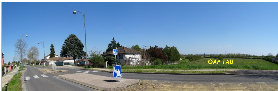
Traversée piétonne sécurisée au droit de la partie Est de l'OAP
