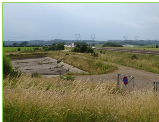
Bassin d'orage routier le long de l'autoroute A 42 aux Bioléas
