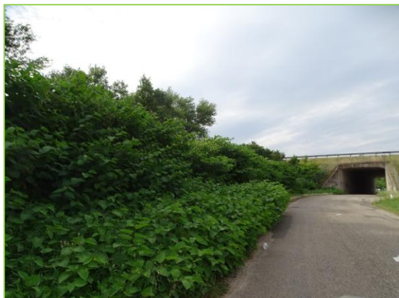
Renouée de Sakhaline route de la Grande Dangereuse
