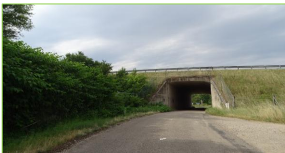
Passage de la route de la Grande Dangereuse sous l'autoroute A 42
