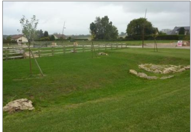
Exemple de petit bassin pluvial créé au sein d'un espace vert
