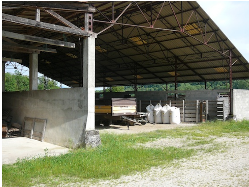
Le seul bâtiment agricole sur la commune
