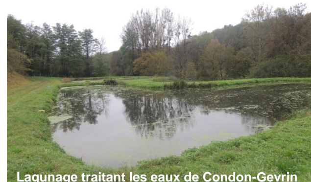
Lagunage traitant les eaux de Condon-Gevrin
