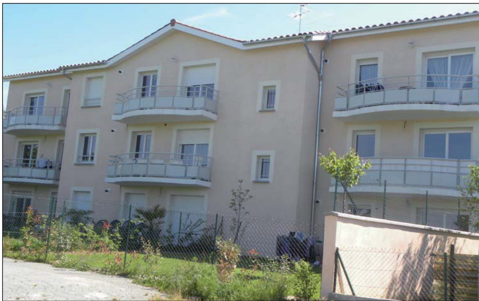
Rue du Frêne- Reprise d'un fronton au centre du bâtiment que l'on retrouve sur la Mairie
