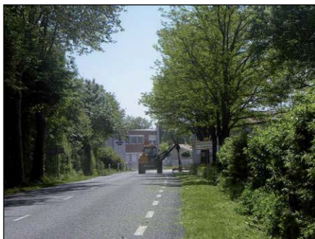
Entrée Nord RD 66
