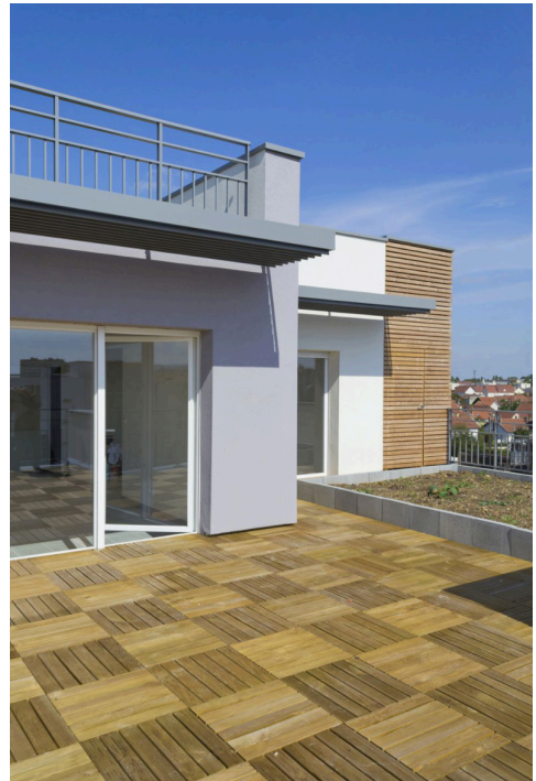
Immeuble en jardin générant des terrasses attractives
