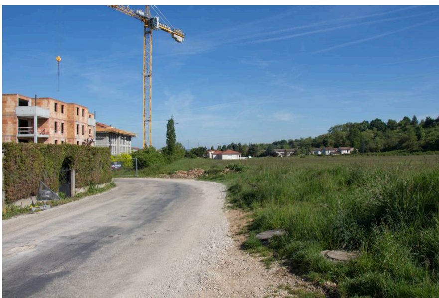
Vue du secteur depuis la rue des Apôtres.
