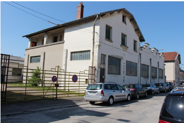
Ancien bâtiment Transports Cordier - rue Emile Bravet
