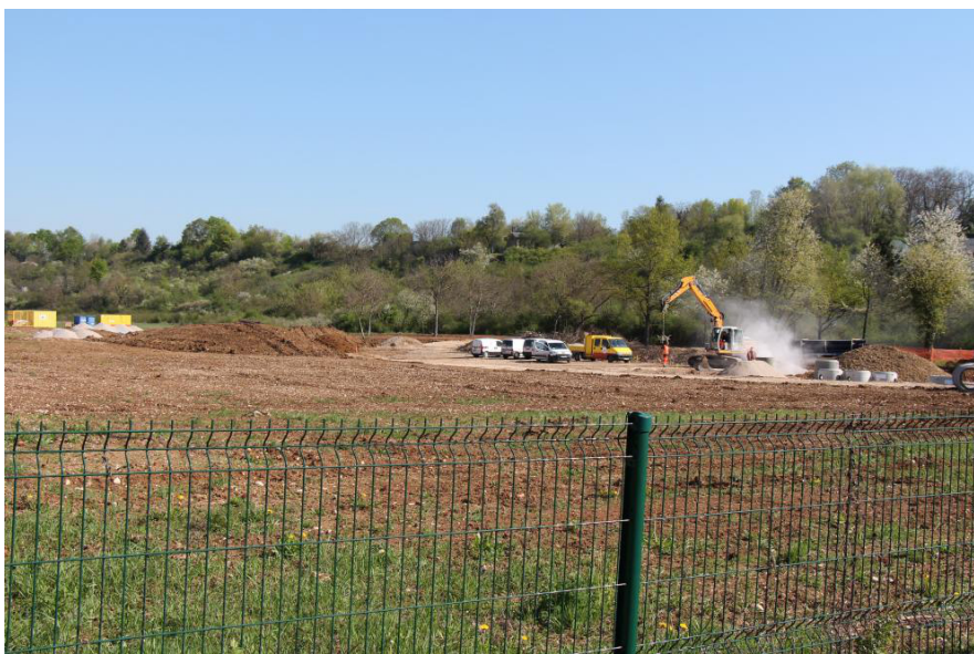
Travaux d'aménagement en cours à proximité du secteur
