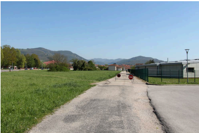
Ruelle située au Nord du centre nautique à requalifier.
