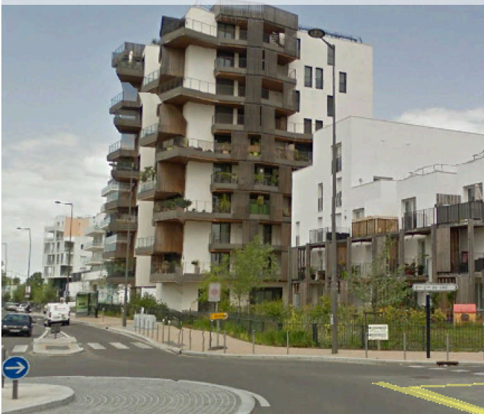
Exemple de façade qualitative d'immeuble repère
