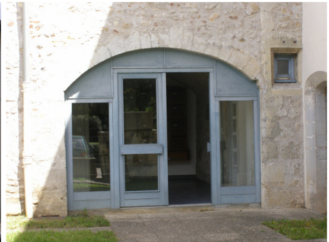
Détail sur entrée
