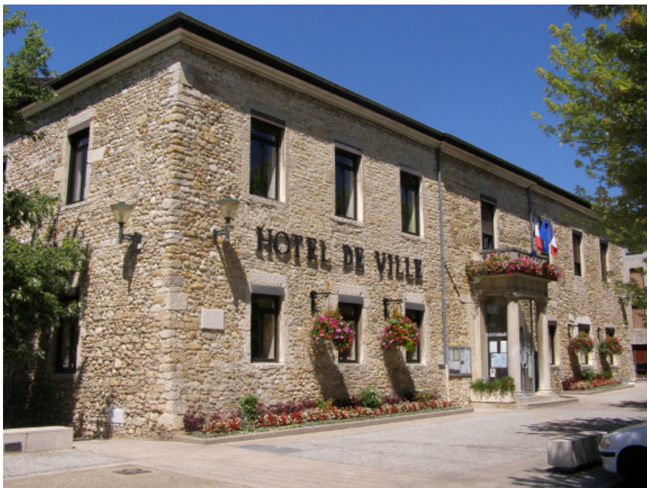
Détail du porche
