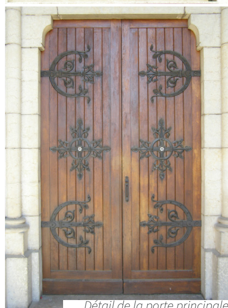
Détail de la porte principale
