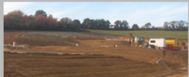
Terrassements importants pour l'implantation d'activités
