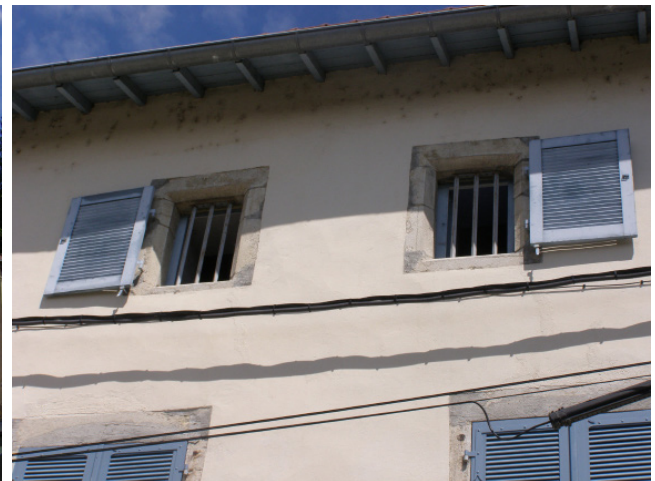
Détail sur ouvertures
