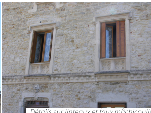
Détails sur linteaux et faux mâchicoulis
