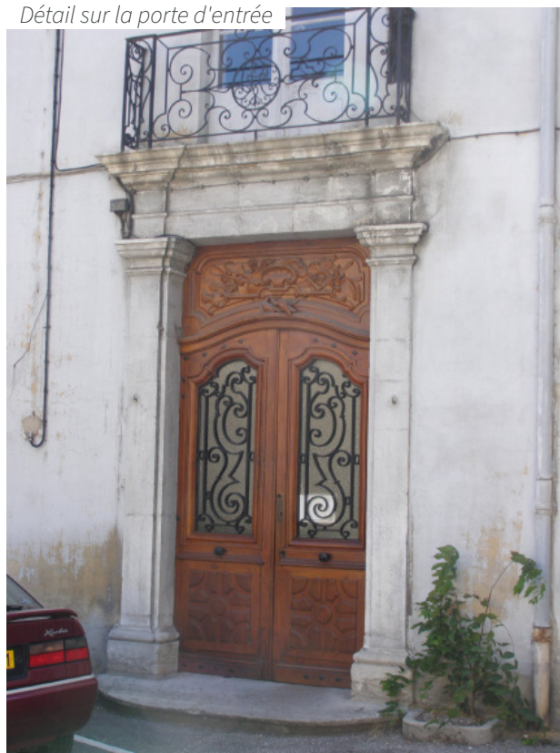
Détail sur la porte d'entrée
